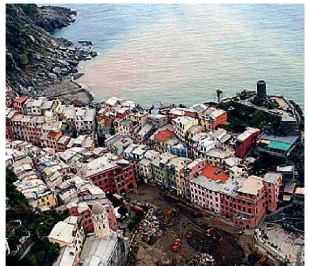
PRIMA E DOPO La nuova piazza appena inaugurata e, sotto, come era dopo l'alluvione
